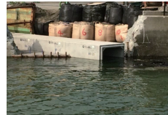
写真-3 山口県大島郡周防大島町（伊保田港） ボックスカルバート 1200×1200mm
